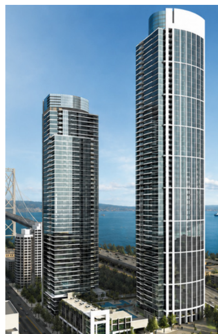
Рисунок 1 – Общий вид жилого комплекса One Rincon Hill
