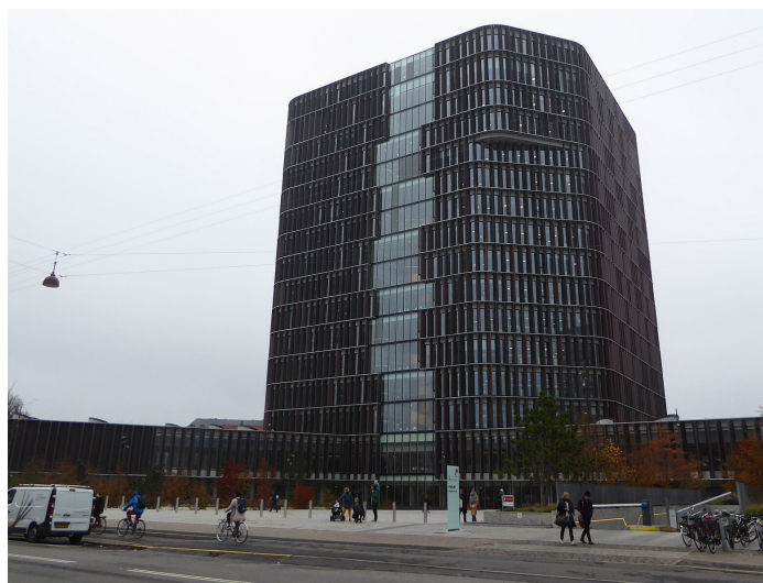
Рисунок 3 – Фасад здания «Мэрск Тауэр» с регулируемыми солнцезащитными панелями как средство зонированного управления дневным светом, бликами и визуальным комфортом помещений
