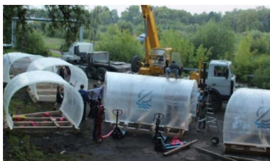
Рисунок 9 – Секция подводного тоннеля из акрила [15]
