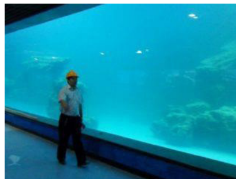
Рисунок 1 – Литая стеновая УФ акриловая панель для аквариума, океанариума [5]
